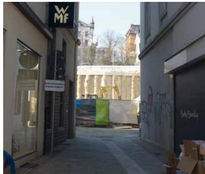
Gemeindebadgässchen, Neubau Parkhaus Coulinstraße
