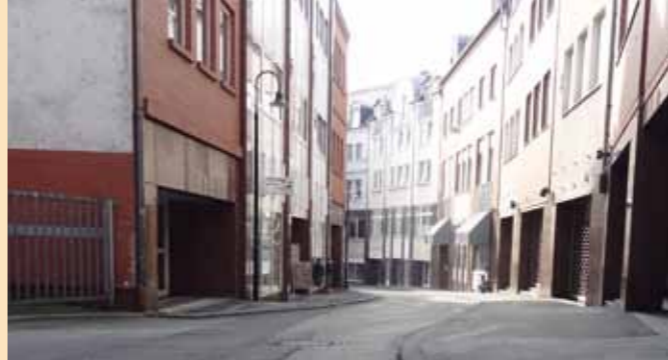
Derzeitiger Ausbau der Hochstättenstraße
