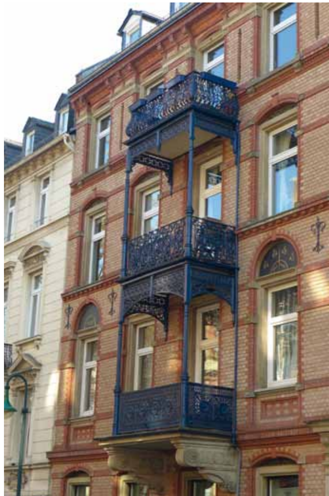
Erhalt historischer Fassaden
