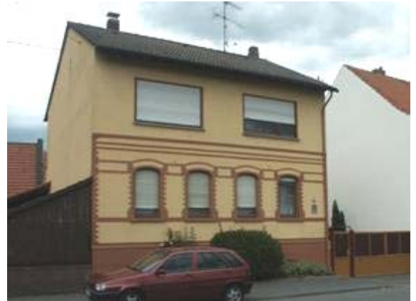
Aufstockung eines ursprünglich eingeschossigen gründerzeitlichen Wohnhauses
