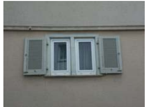
Schmuck an verputzten Fachwerkhäusern
