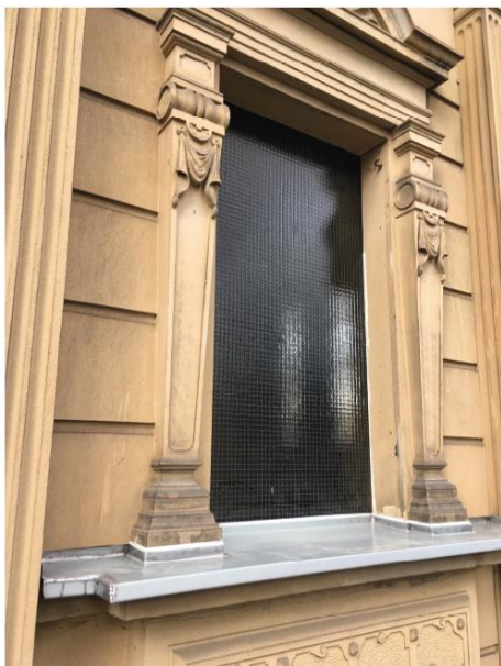
Abbildung 6 Drahtglasfenster
