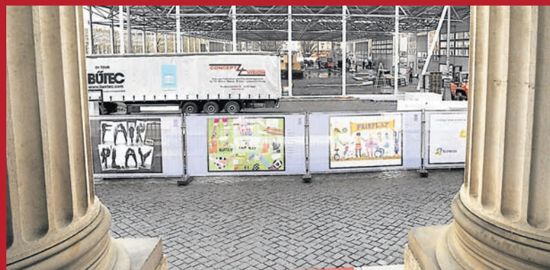
Blick durch die Kurhaus-Säulen: Keine Mühen scheut die Stadt, um den Ball des Sports während des Neubaus der Rhein-Main-Hallen in Wiesbaden zu halten. Auf dem Bowling Green entsteht eine Arena aus Aluminium.
