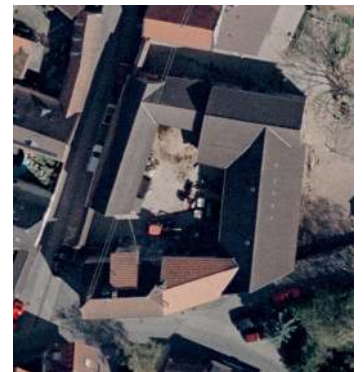
Giebel- oder traufständige Hofanlage des 16. und 17. Jahrhunderts mit Torhaus bzw. Tor und Nebengebäuden
