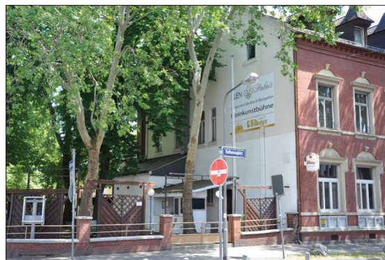
Außenanlagen Gastronomie / Kleinkunstabühne, Stettiner Straße
