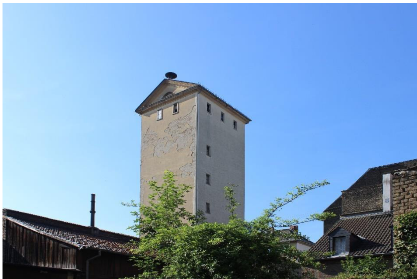
Schlauchturm ehem. Feuerwehr, Wilhelm-Tropp- Straße 22
