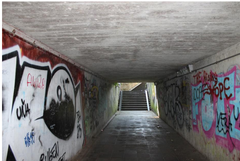
Unterführung Bahn- gleise, Äppelallee
