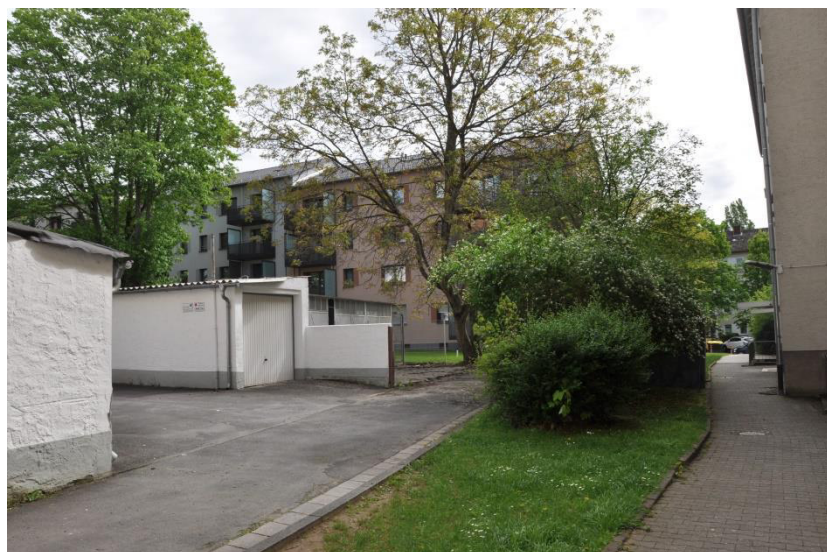
Innenhof, Borkholder Straße
