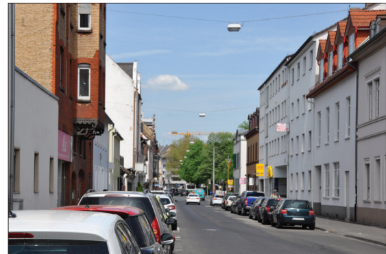
Erhöhte Hitzebelastung durch unzureichende Verschattung des Straßenraums
