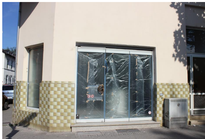
Nachnutzung leer- stehende Bäckerei (Umnutzung Kiosk), Rathausstraße
