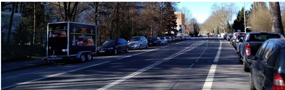
Abbildung 33: Radwegeführung auf der Erich-Ollenhauer-Straße ohne Sicherheitsabstand zu parkenden Autos (ProjektStadt 2018)
