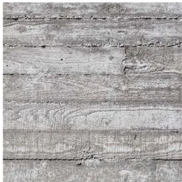
Betonflächen teilweise als Sichtschalung (Bretterschalung)
