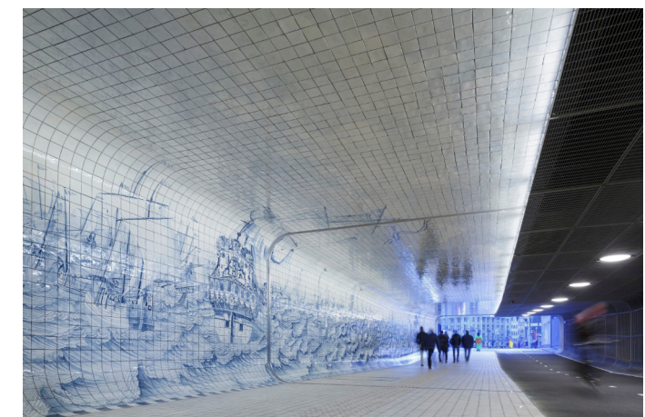
Abbildung 132: Der Tunnel für Fußgänger:innen und Radfahrer:innen am Bahnhof in Amsterdam zeigt ein gelungenes Beispiel für die funktionale Trennung von Verkehrsteilnehmenden mit verschiedenen Geschwindigkeiten sowie die wertige Gestaltung durch Beleuchtung und Oberflächenmaterialien, um Angsträume zu vermeiden. Bild: © Jannes Linders (Fotograf), Benthem Crouwel Architects
