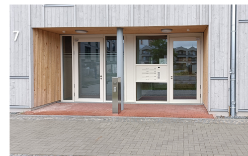
Abbildung 29: Hauseingang im Ellener Hof mit taktilem und optischem Kontrast. Bild: © Bremer Heimstiftung / p+t planung
