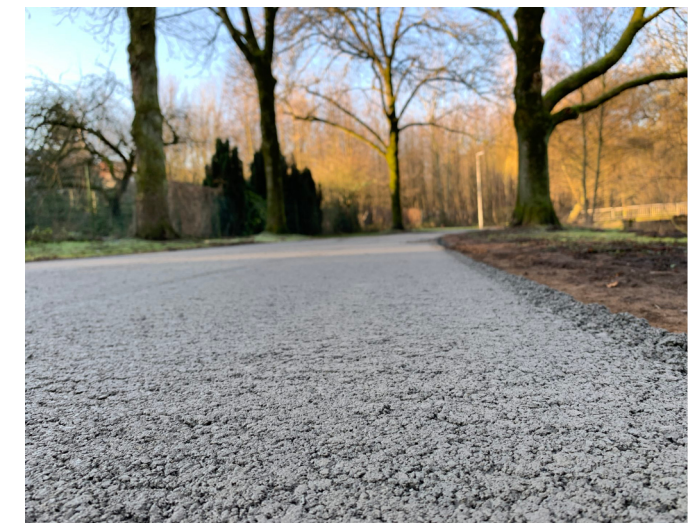
Abbildung 108: Wassergebundene Decke mit guter Rollbarkeit. Bild: GEM mbH / mags Mönchengladbacher Abfall-, Grün- und Straßenbetriebe AöR
