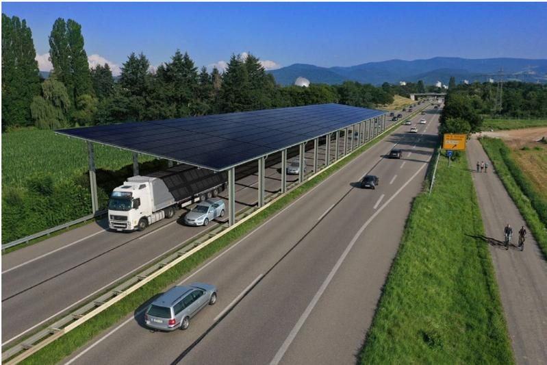
**Abbildung 45: Visualisierung einer bifazialen PV-Anlage über einer Autobahn**
