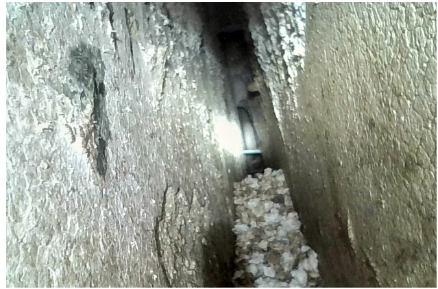
Abb. 3 Bruthöhle in Fassadendämmung. Zwischen der Hauswand (links) und dem Putz (rechts) haben Sittiche das Styropor auf einer Länge von 1,80 m und einer Höhe von gut 30 cm vollständig entfernt. Foto: Oliver Weirich
