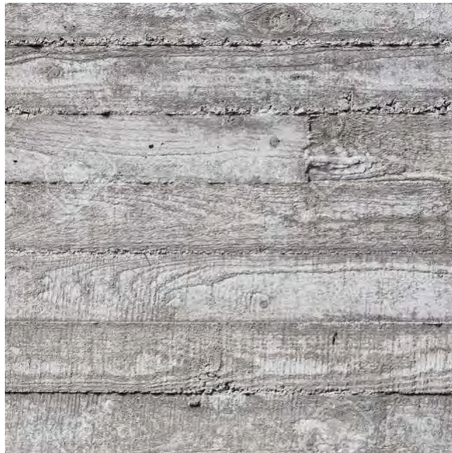
Betonflächen teilweise als Sichtschalung (Bretterschalung)
