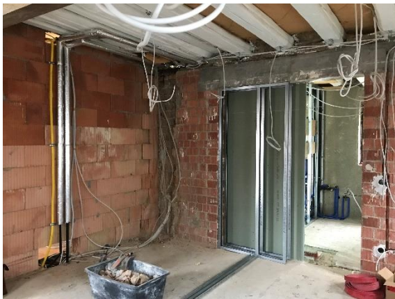
Abb. 4: Bauzustand künft. Vereinszimmer (04.07.2024)
