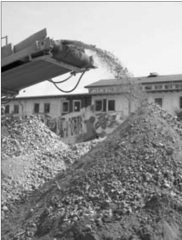
Abb. 8: Mobile Aufbereitungsanlage zum Zerkleinern von mineralischem Bauschutt
