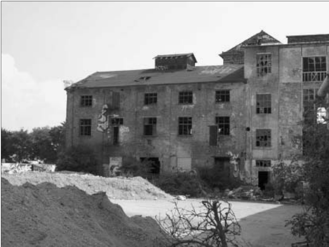
Abb. 5: Beispiel für ein abzubrechendes Gebäude mit ehemals gewerblicher Nutzung, bei dem im Vorfeld ein Abbruch- und Entsorgungskonzept erstellt wurde
