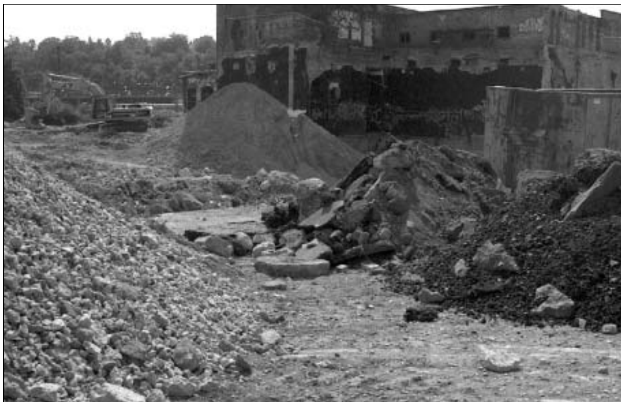
Abb.1: Verschiedene Bauschuttmaterialien auf einer Baustelle
