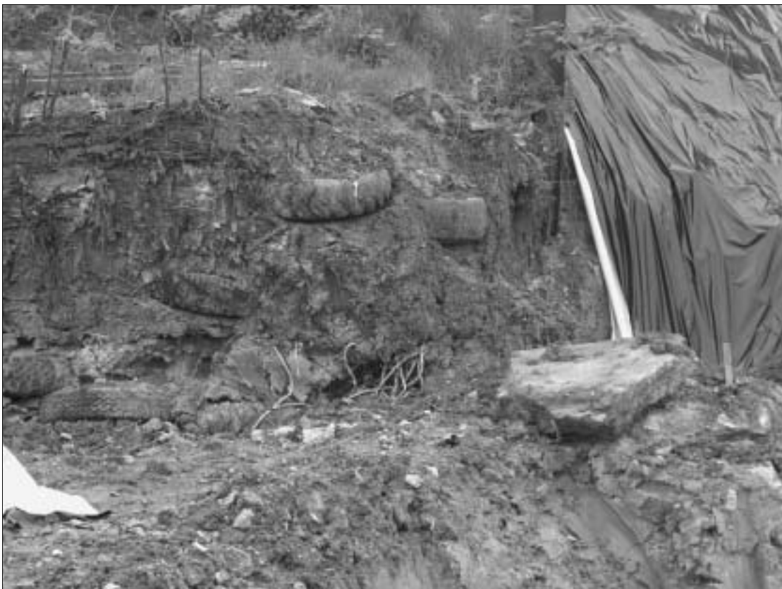
Abb. 4: Grubenwand einer Baugrube im Bereich einer zuvor unbekanntem Altablagerung/ehemaligen „wildem“ Müllkippe
