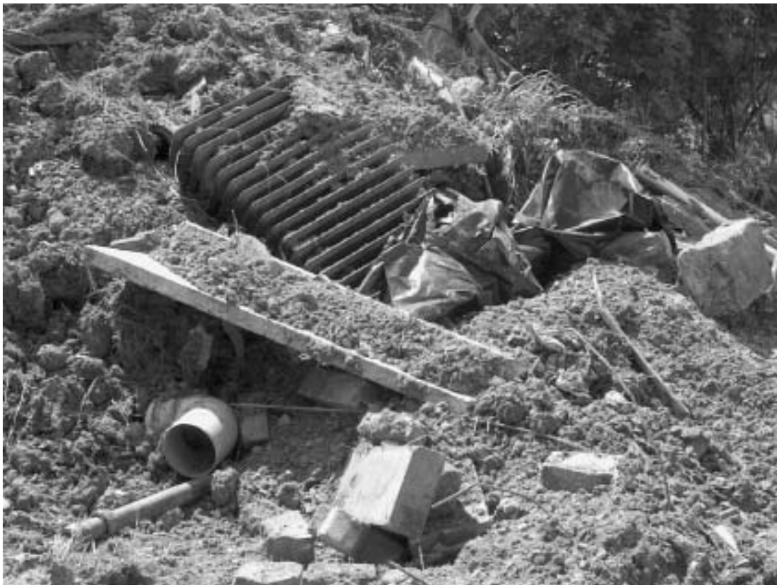
Abb. 3: Abfallrechtlich relevanter Aushub im Bereich einer Altablagerung/ehemaligen Hausmüldeponie
