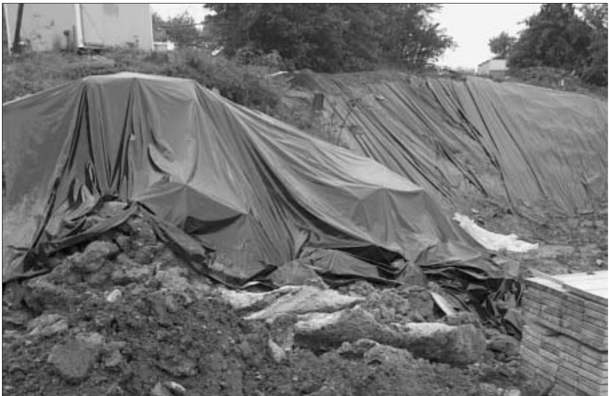
Abb. 10: Planenabdeckung schadstoffhaltigen Aushubs zum Schutz vor Verwehung und eindringendem Niederschlagswasser
