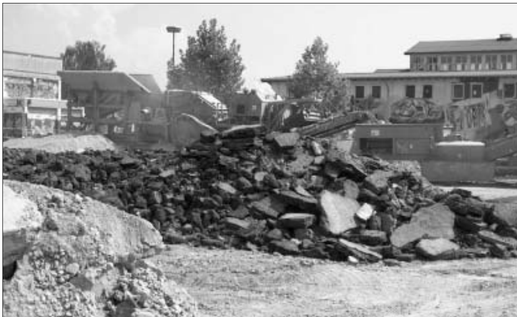
Abb. 7: Gesonderte Bereitstellung einer teerhaltigen Schwarzdecke
