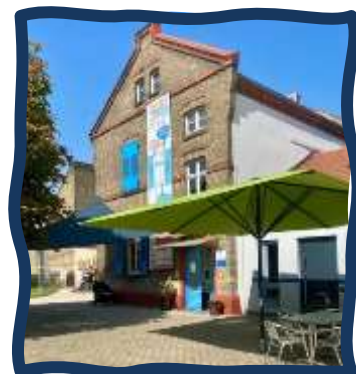
Bauhof Biebrich; Foto: Privat
